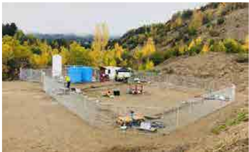
Svelvik CO 2 Field Lab. Inngjerdet område med injeksjonsbrønn, fire overvåkingsbrønner, to tanker (blå) for vanninjeksjon, en tank (hvit) for CO 2 -injeksjon og et enkelt kontroll- og instrumenteringsrom. Foto: SINTEF
